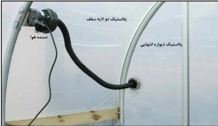
شکل ۲۳- چگونگی قرارگیری دمنده پوشش دو لایه نزدیک دیوار انتهایی
