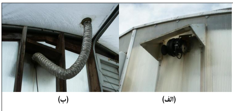
شکل ۲۲- قرارگیری دمنده پوشش دو لایه در بیرون از گلخانه. تصویر دمنده روی دیوار کناری (الف) و نحوه انتقال هوای فشرده به سقف پلاستیکی دو لایه (ب)
